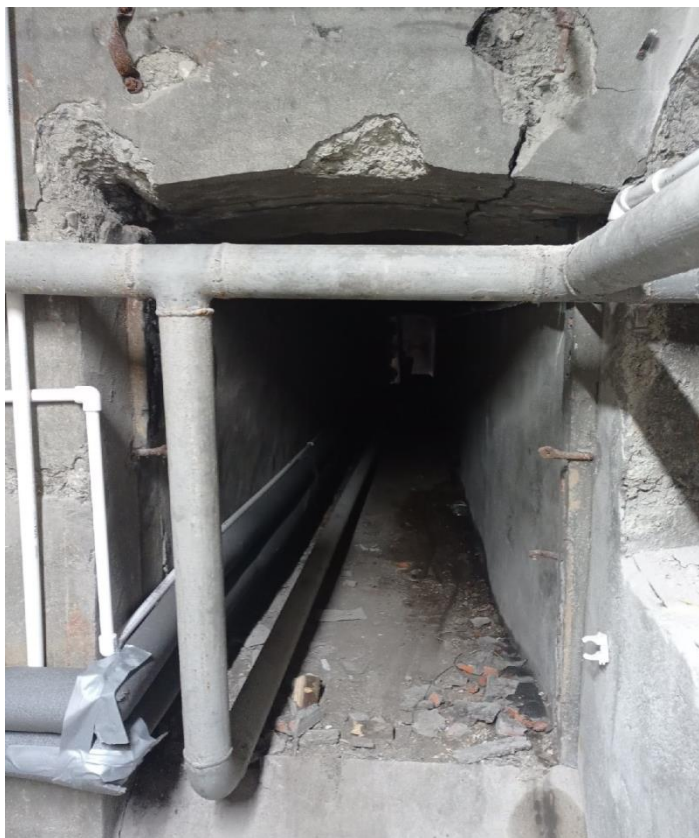
Система отопления, использовавшаяся ранее
